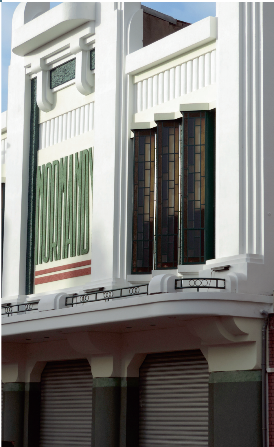
Façade rénovée de l'ancien cinéma Normandy en 2022 @C.d'Abouville
